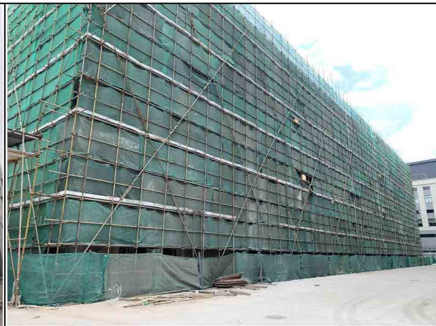
项目北面：在建厂房
